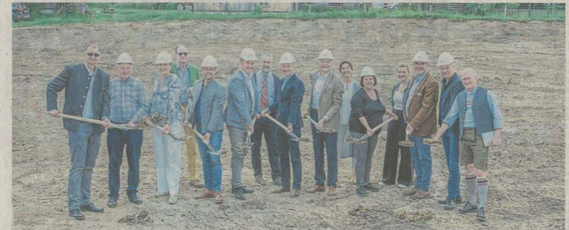
Große Runde: Förderer, Planer und Unterstützer des Oberland-Hospizes setzten gestern den ersten Spatenstich.
