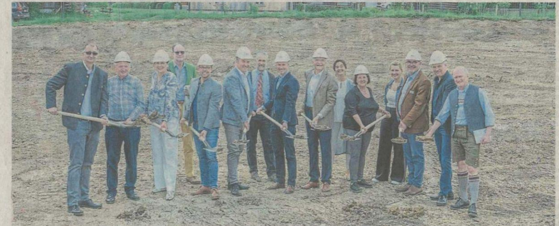
Große Runde: Förderer, Planer und Unterstützer des Oberland-Hospizes setzten gestern den ersten Spatenstich.
