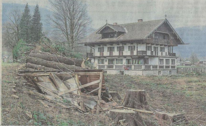
Die Tage des Josefheims sind gezählt: Demnächst wird der Abbruch des alten Gebäudes am Löblweg beginnen. Die ersten Bäume auf dem Areal wurden bereits gefällt. Hier entsteht das neue Oberland Hospiz. FOTO: THOMAS FLEITENBERG
