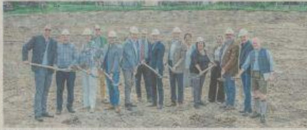
Bad Wiessee: Politiker, Planer und Mitarbeiter des Oberland-Hospizes nehmen teil am ersten Spatenstich.
