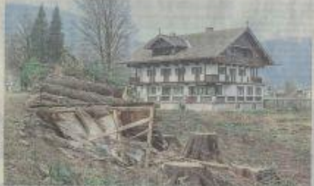
Die Reste des einstigen Schlosses sind im Bild zu sehen. Die Arbeiten werden auf dem Gelände des Schlosses durchgeführt. Der Bau des Oberlauf-Parkplatzes soll ebenfalls folgen.
