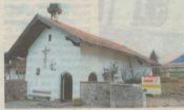
Die Josefskapelle am Wiesseer Löblweg bleibt erhalten und soll mit dem künftigen Hospizgebäude ein Ensemble bilden. Foto: Gemeinde
